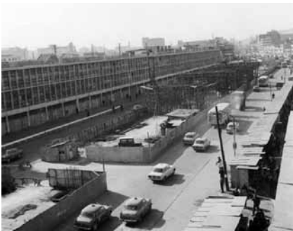
1968년 청계고가도로 공사 모습
